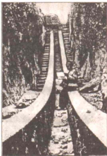
Рис. 171. Секстант Самаркандской обсерватории Улугбека.
