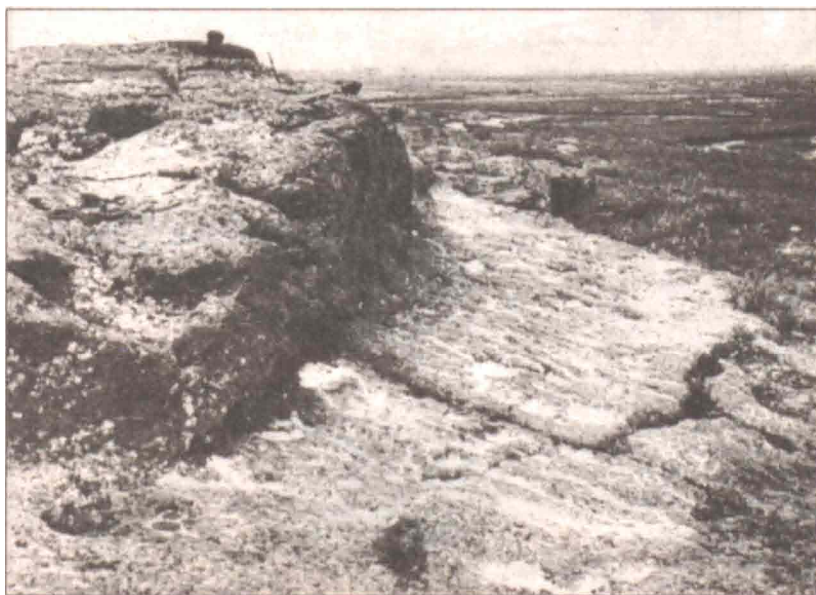
Рис. 59. Главное сооружение тонкого обогащения («доводки»).
