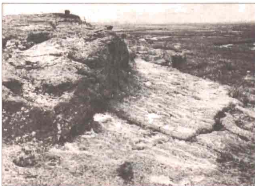
Рис. 59. Главное сооружение тонкого обогащения («доводки»).
