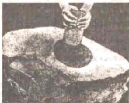
Рис. 95. Схема дробления руды в ступе на Зода.
