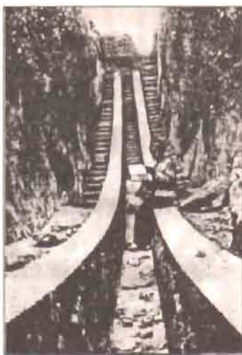
Рис. 171. Секстант Самаркандской обсерватории Улугбека.
