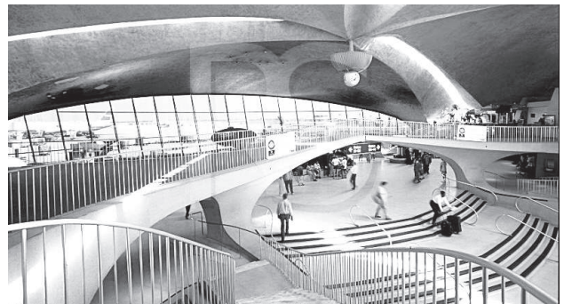
Նկար 57. ա, բ, TWA օդանավակայանը Նյու Յորքում, ճարտարապետ Էրո Սաարինեն, 1962 թ. (TWA Flight Center, Eero Saarinen): Կրկնակի կորության թաղանթների կիրառում: ա - ընդհանուր տեսք, բ - ինտերիեր:
