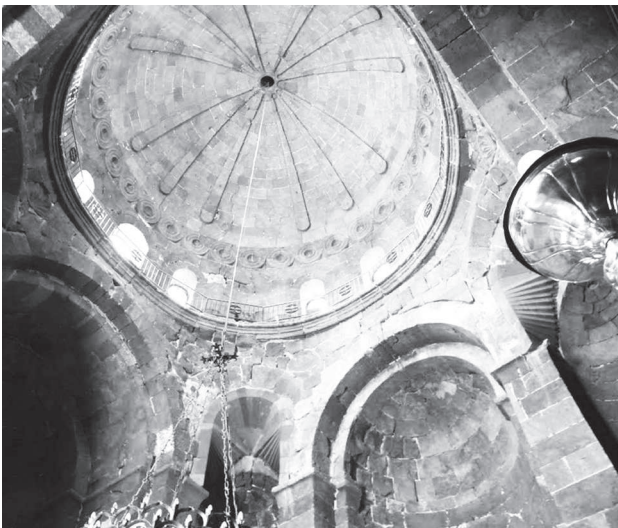
Նկար 48. Սբ. Հովհաննես տաճարի գմբեթը, գմբեթարդները, տրոմպային անցումները:
