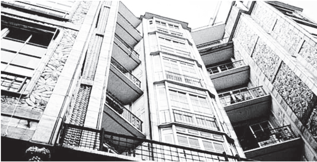
Նկար 39. Բնակելի տուն Փարիզի Ֆրանկլին փողոցի վրա, 1905 թ., ճ-տ Օգյուստ Պերրե (Rue Franklin Apartments, Auguste Perret): Առաջին երկաթբետոնյա շենքը: Ճակատում արտացոլված են կմախքի հորիզոնական և ուղղահայաց տարրերը:
