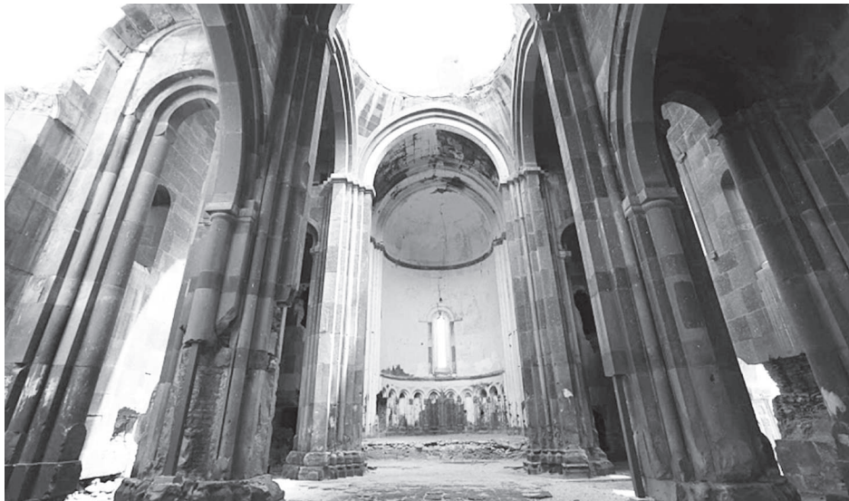
Նկար 126. Անիի Մայր տաճար, 988-1001 թթ., ճ-տ Տրդատ: Ինտերիեր: Փնջածն մույթեր:
