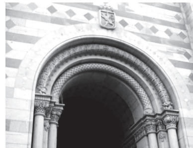
Նկար 40 ա,բ: Վերևում՝ կամարի կառուցվածք՝ ա-պլինթ, ճ-կամարի կրունկ կամ իմպոստ, Վ-կամարերես, Գ- փականաքար, Ժ-կամարաղեղ կամ արխիվոլթ:
