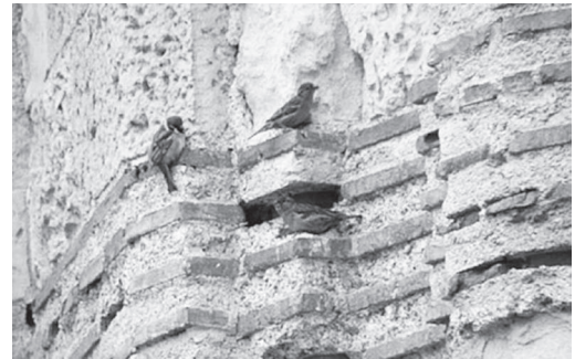
Նկար 117. ա, բ. Բյուզանդական շինարարական տեխնիկա՝ պլինթոսի կիրառմամբ, Ս. Կոսմասի և Դամիանի եկեղեցի Ագիոյ Անարգիոյ քաղաքում, Հունաստան, 11-րդ դար:
