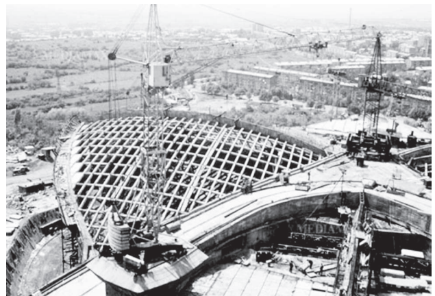
Նկար 58. ա, բ, Մարգարիտապետի համալիր Երևանում, 1980-84 թթ.: Դ-ներ Կ. Հակոբյան, Ա. Թաթևյան, Հ. Պողոսյան, Ս. Խաչիկյան, Գ. Մուշեղյան, քանդակագործ Ֆ. Առաքելյան: Կրկնակի կորության թաղանթի և վանտային կառուցվածքի օրինակ. ա - արտաքին տեսք, բ - ծածկի երկաթբետոնյա թաղանթի կառուցումը:
