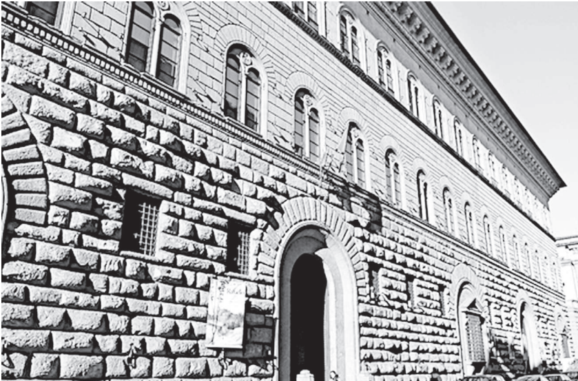
Նկար 83. Մեդիչի-Ռիկարդի պալացոն Ֆլորենցիայում, XV դար, ճարտարապետ Միկելոցցո: Երեք հարկերի պատերը լուծված են տարբեր մշակվածության քարերով:
