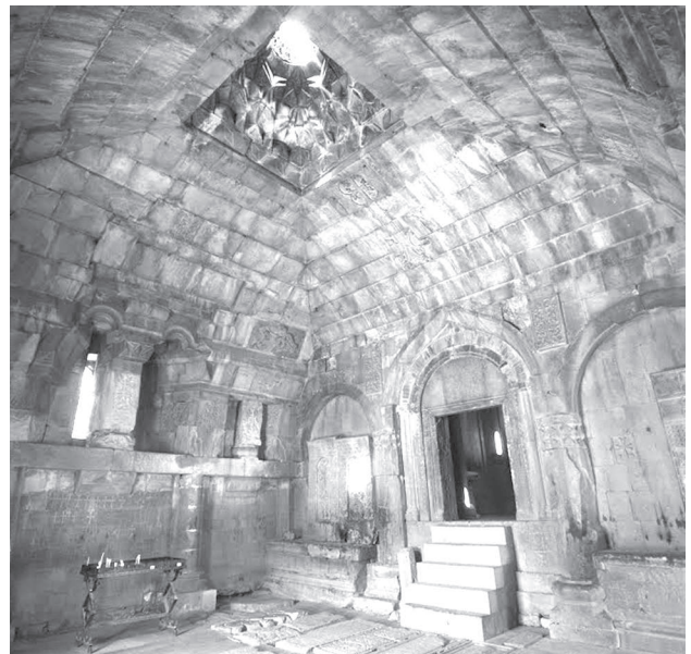
Նկար 46. Նորավանքի Սբ. Կարապետ եկեղեցու գավիթը ծածկված է գոց թաղով: Թաղի կենտրոնում՝ շքաքարե երդիկ:
