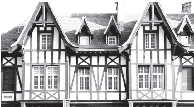
Նկար 37 ա, բ: Ֆախվերկային կառուցվածքի օրինակներ:
