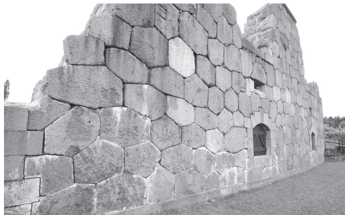
Նկար 30. Պատի շարվածք բազմանկյուն քարերով:
