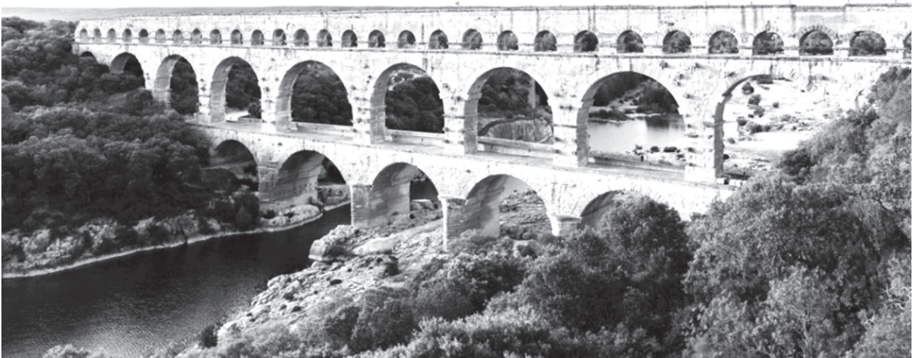
Նկար 60. Գարդի կամուրջ, Ֆրանսիա, 2-3 դդ.: Կամարները մեծանում են ծայրերից դեպի մեջտեղ՝ ոսկե հատման համաչափությամբ:
