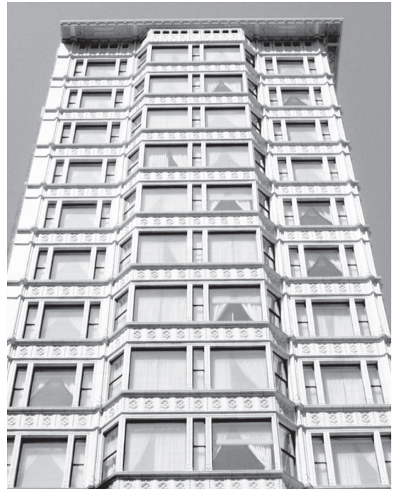
Նկար 38. Ռիլայնս ընկերության շենքը Չիկագոյում, 1890-95 թթ., ճ-տ Ջոն Բուք (Reliance Building in Chicago, John Root): Շենքի ճակատը, ինչպես և ամբողջ ներքին կմախքը կազմված է հորիզոնական և ուղղաձիգ կառուցվածքային տարրերով:
