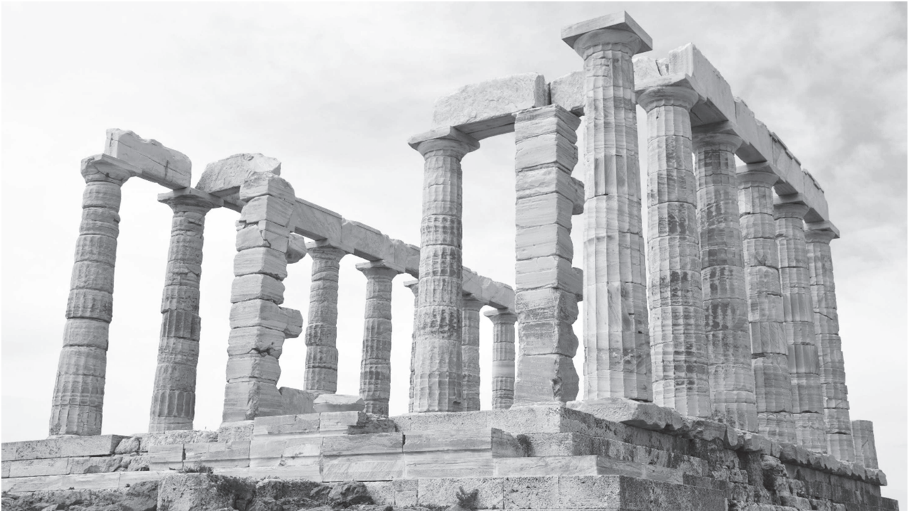
Նկար 31. Հենակա-հեծանային համակարգի օրինակ՝ Պոսեյդոնի տաճարը Սունիոնում, Հունաստան, 444-440 թթ. մ.թ.ա.: Դորիական սյունակարգ (օրդեր):
