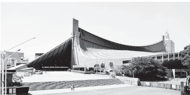
Նկար 54. Կախովի՝ վանտային կառուցվածքներ 57 :
