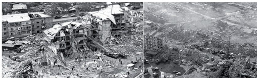
Рис.2.3. Руины многоэтажек г. Спитак, после 07/11/1988 Спитакского землетрясения Армения [47].
