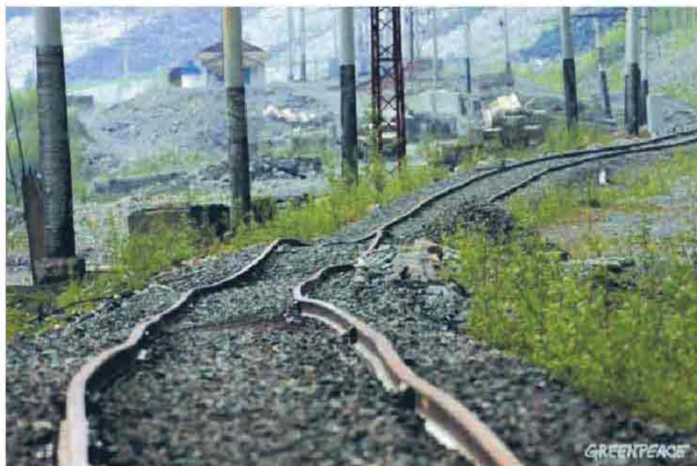
Рис. 5.4. Зона «вечной мерзлоты». Деформация железной дороги в Сибири (фото С. Ю. Пармузина)
