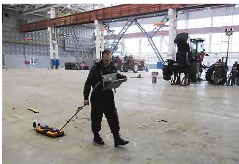
Рис. 212. Процесс георадарной съемки
