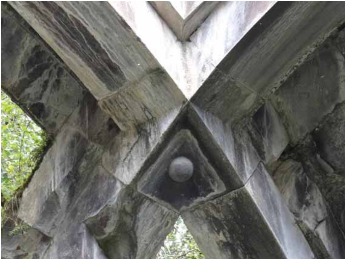
Նկ. 12. Դեղձուտի վանքի գավթի խաչվող կամարները
