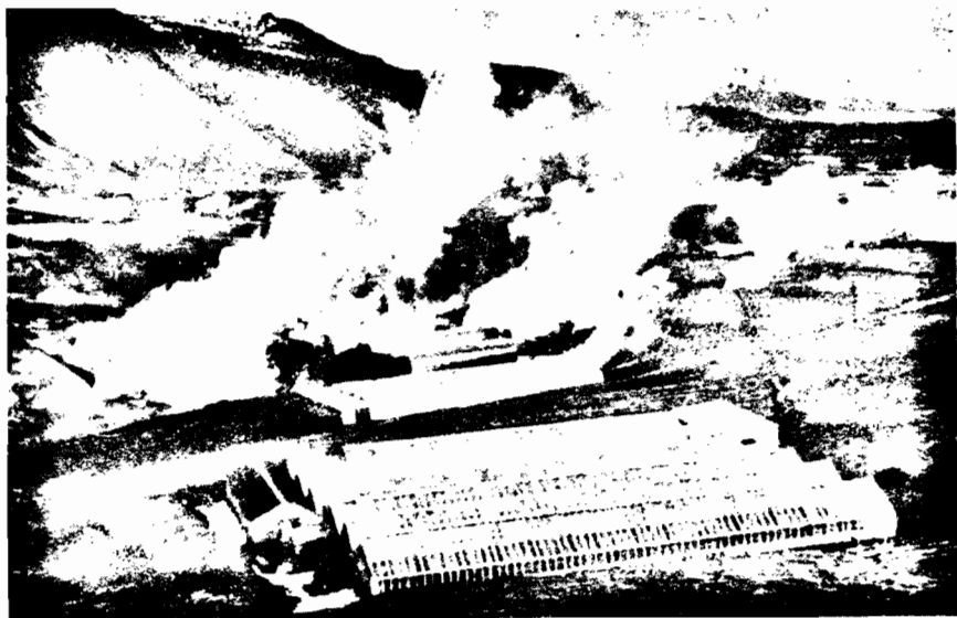
Теплицы на горячей воде гейзеров в Исландии
